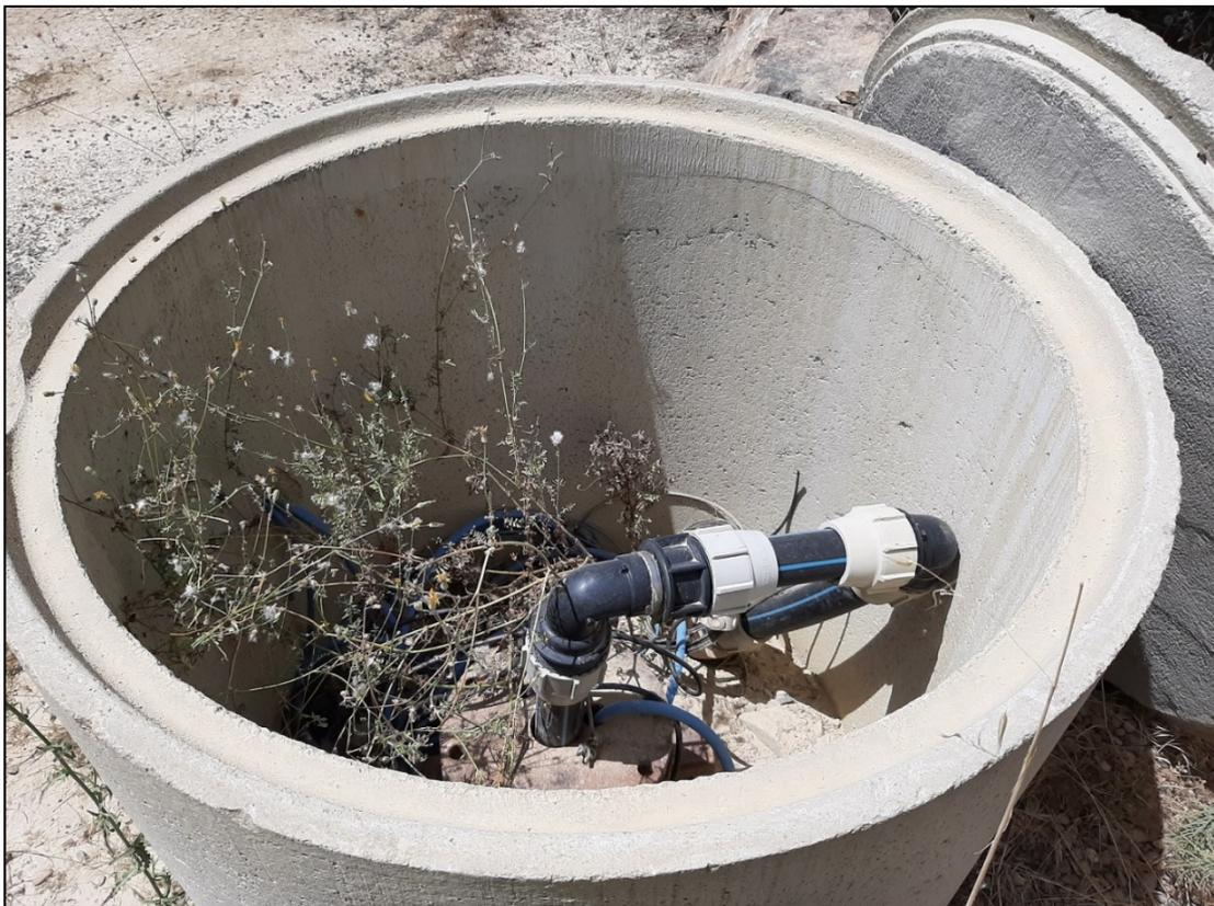
Figure 13. Forage alimentant les sanitaires et le système d'aspersion
